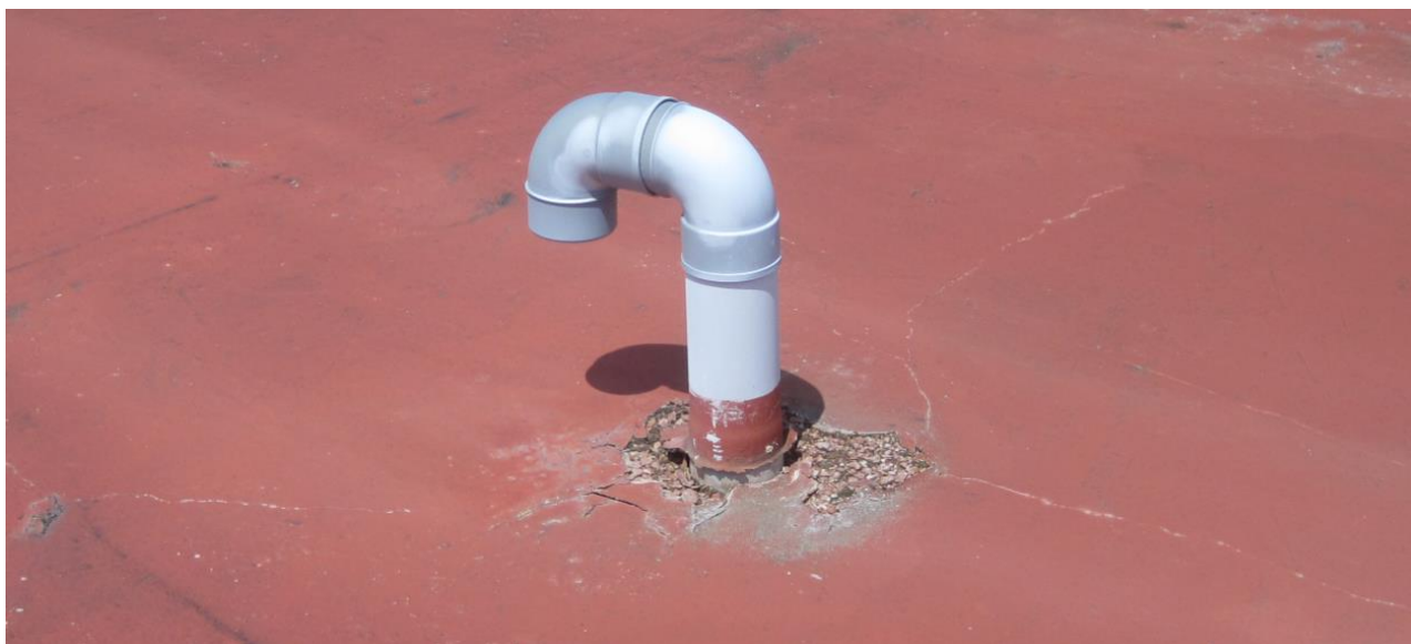
Figura 15: Rotura impermeabilización en puntos singulares
