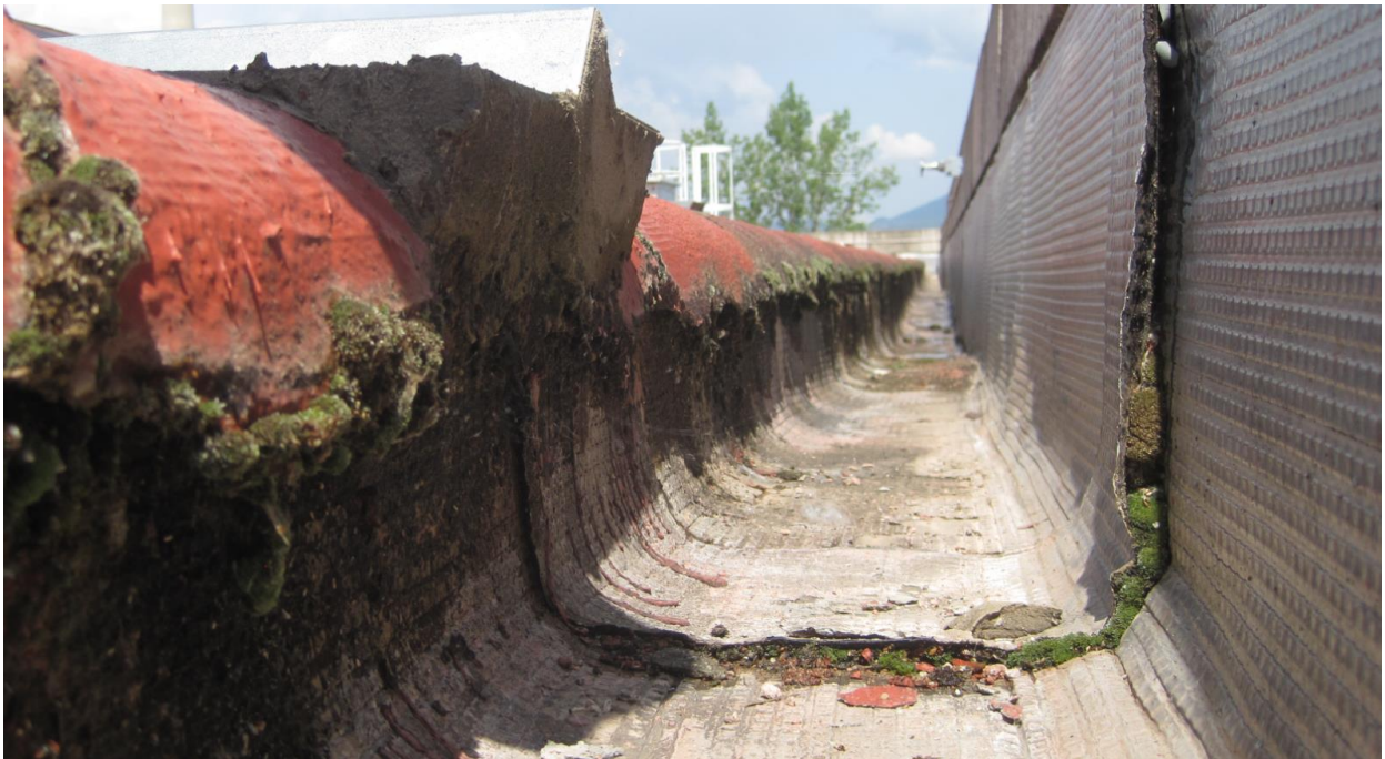
Figura 17: Musgo en solape de la impermeabilización de la junta dilatación en el canalón
