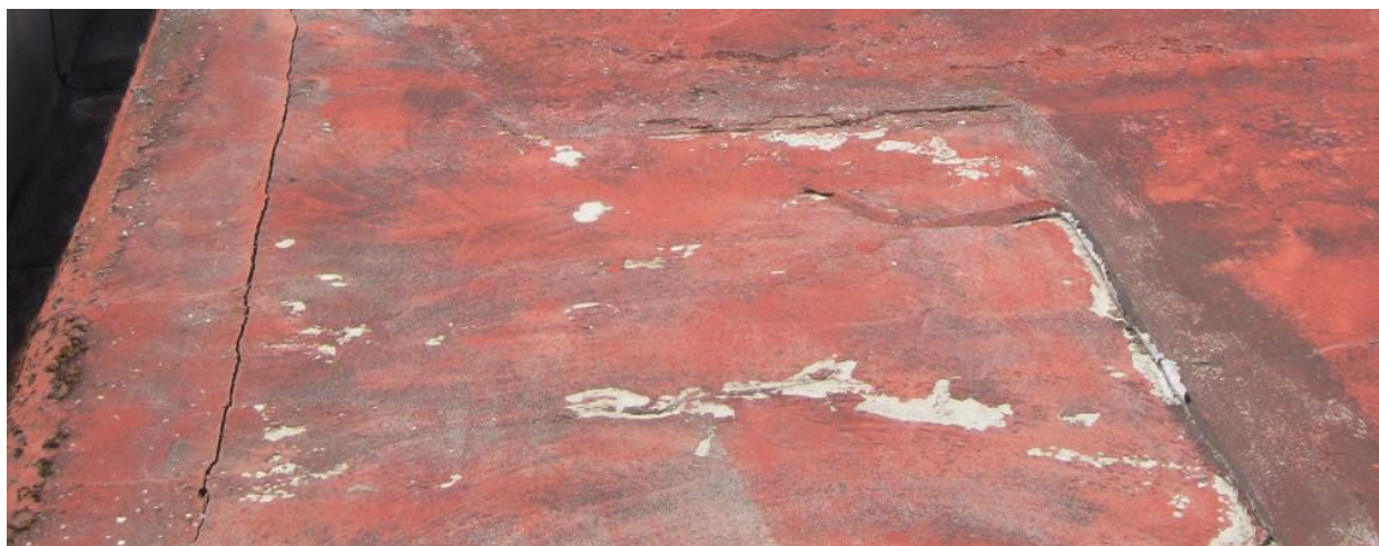
Figura 14: Rotura generalizada capa superior de impermeabilización
